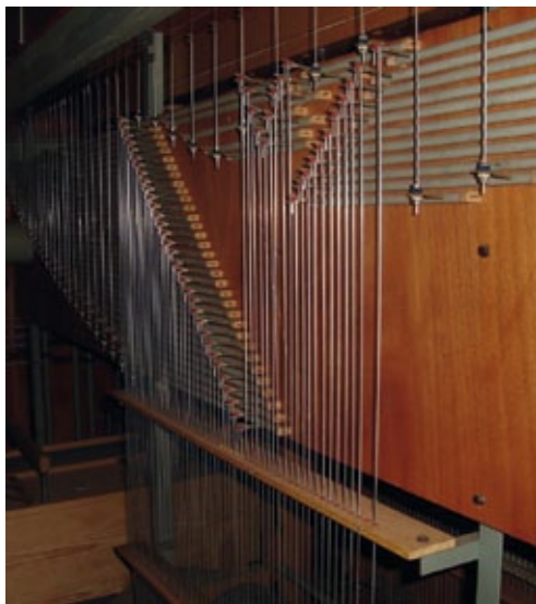
Neues Wellenbrett zum Hauptwerk, 1969
